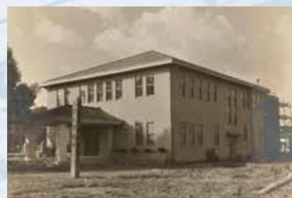
▲竣工直後の三哲文庫(昭和15年11月)
