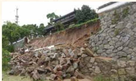
写真2 被災後の大専坊石垣(南面)
